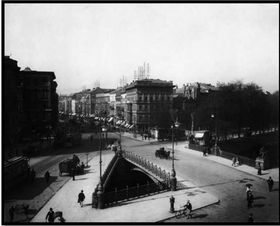
Potsdamer Brücke, Landwehrkanal (W. Titzenthaler, 1900)
