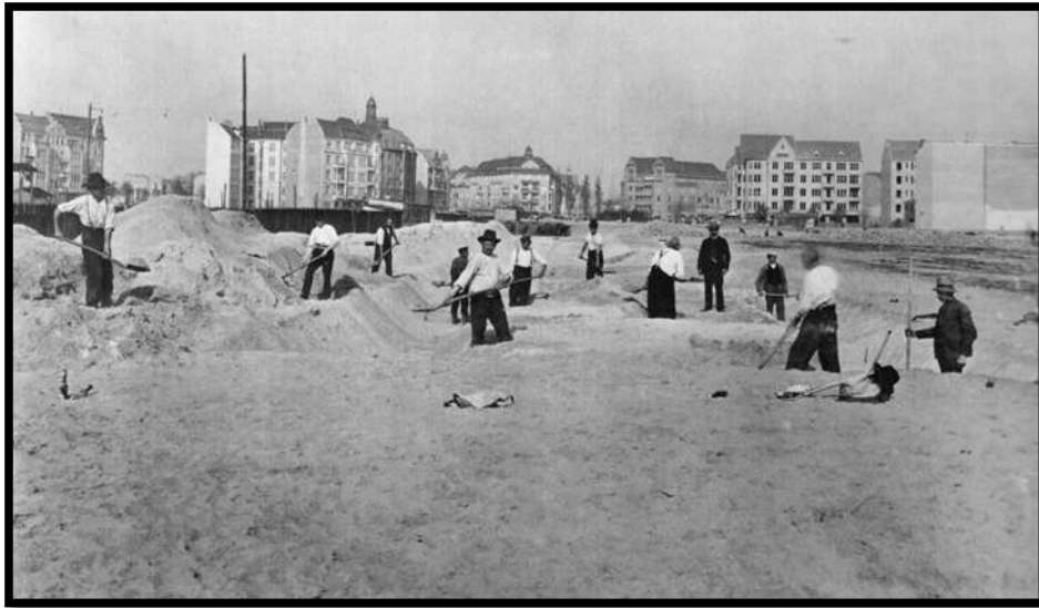
Bodenaushub Innsbrucker Straße, im Hintergrund Bayrischer Platz (1908) (Quelle: EXERZIERFELD DER MODERNE, 2)
